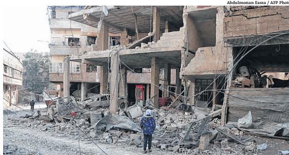
Menina síria olha para escombros de um hospital que foi destruído ontem
