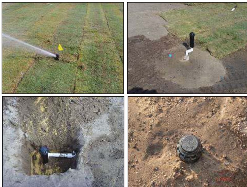
Detalhes dos aspersores no gramado
