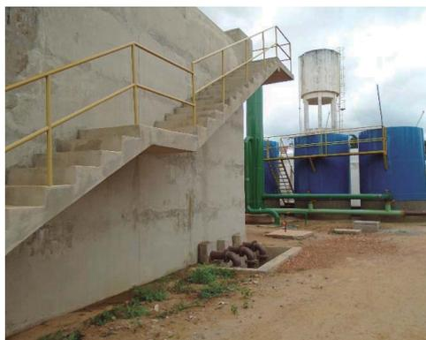
Foto 07 – ETA de Condeúba - Conjunto floccodecantador e filtros
