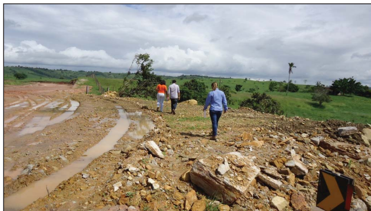
Foto 3. Equipe técnica realizado a inspeção.
