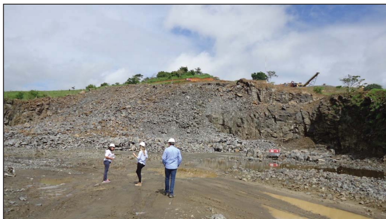
Foto 5. Equipe realizando a inspeção.
