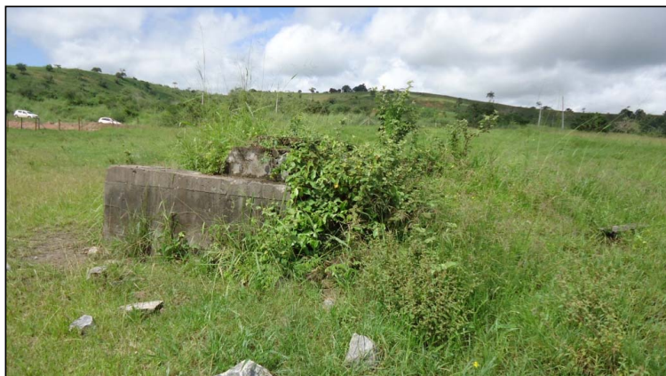
Foto 4. Ruína de estrutura de antiga Usina de Concreto.
