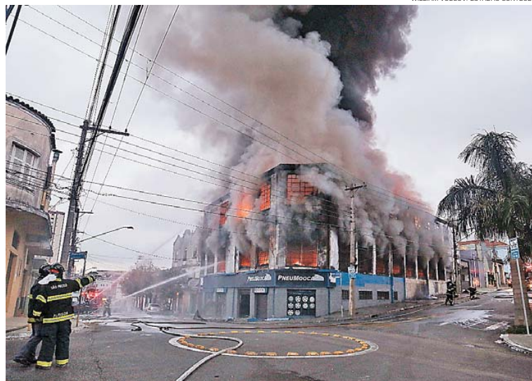
INCÊNDIO ATINGE LOJA DE PNEUS Um incêndio atingiu uma loja de pneus no número 573 da Rua Madre de Deus, na Mooca, bairro da zona leste de São Paulo, no início da manhã de ontem. De acordo com o Corpo de Bombeiros, o fogo começou por volta das 5h30. Dezoito viaturas da corporação foram enviadas ao local, que fica próximo à Avenida Paes de Barros. As chamas foram controladas por volta das 8h e ninguém ficou ferido
