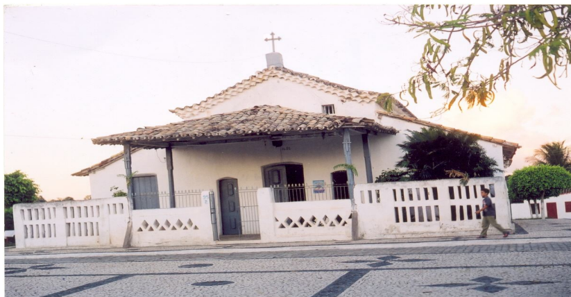
Figura 01-Capela atual da Vila de Itacava
