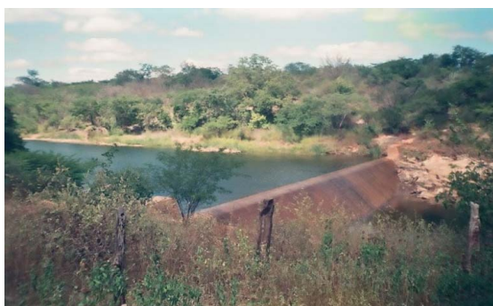
Barragem de Aguadinha
