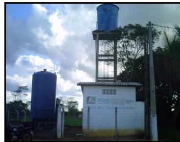
Foto 19 - Vista da eta e reservatório elevado
