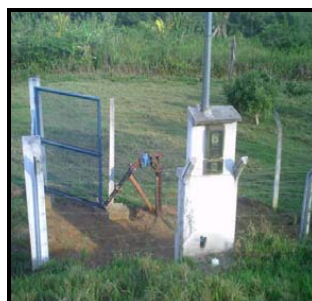
Foto 17 - Portão entrada poço de captação
