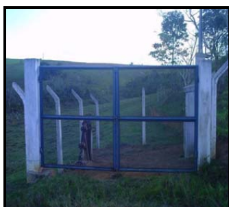
Foto 16 - Portão entrada poço de captação
