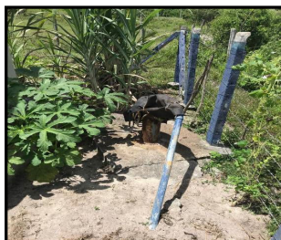
Foto 20 - Poço na localidade de Feira Verde- Lajedão Vazão = 3,33 m 3 /h
